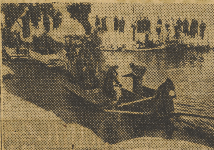
Las tropas alemanas, en un sector del frente del Este, construyen un puente con trineos para atravesar un río (Foto Orbis)
