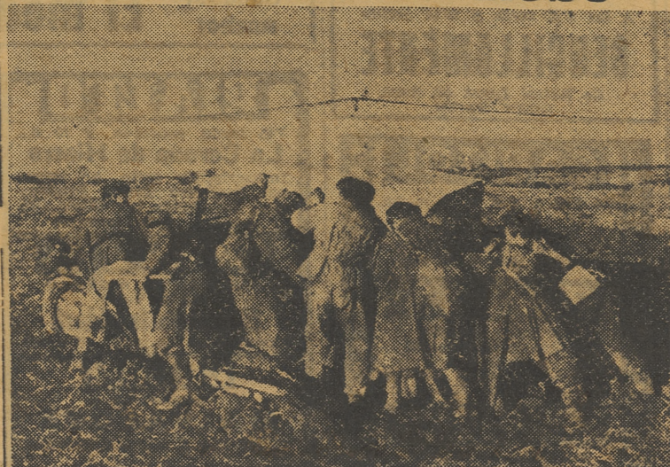
Uno de los principales obstáculos de la lucha es el terreno. Cuando no está cubierto de nieve, el fango dificulta los movimientos de tropas y vehículos. —(F. Presamundo)
