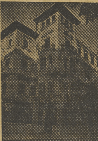
Edificio de la calle de Sorni, en que estuvo instalado el S. I. M.
