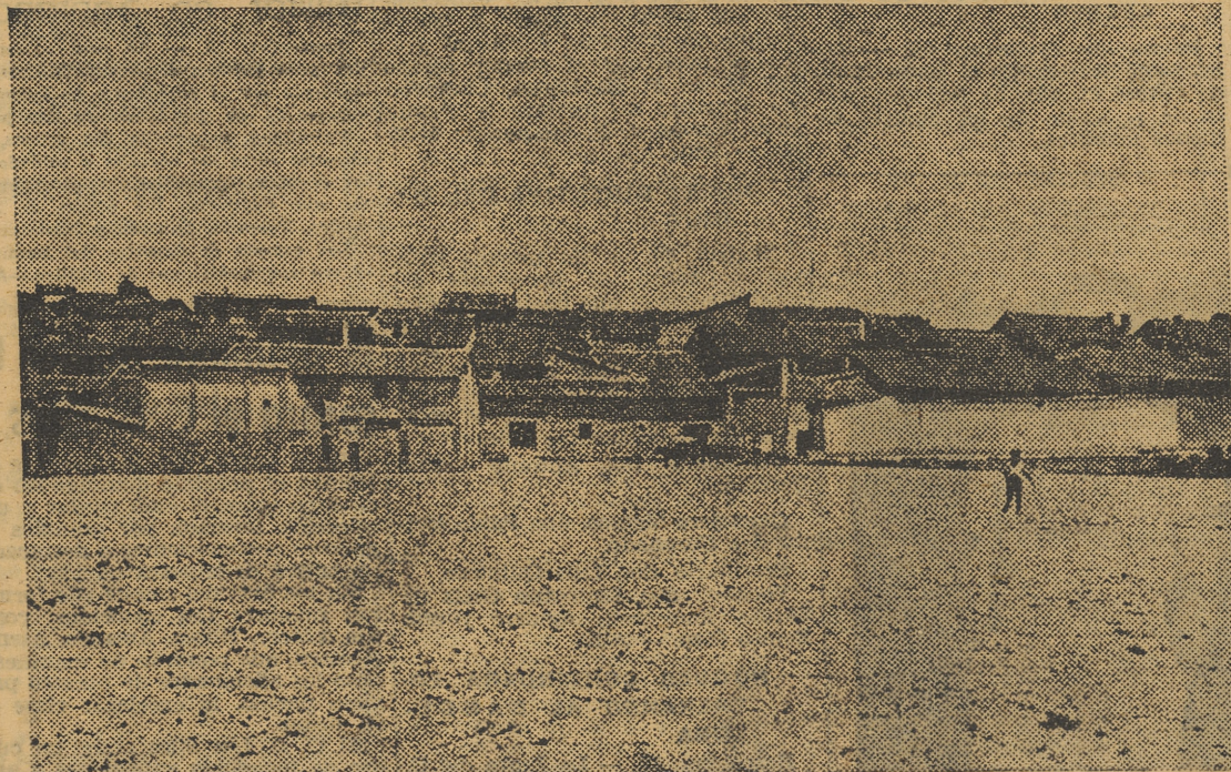
Esta explanada era anteriormente un montículo. Los productores de Puebla del Duc la han allanado para construir sobre ella su grupo de viviendas protegidas
