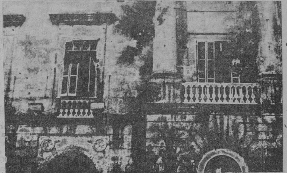
Barcelona.—La fachada del Ayuntamiento y los efectos de los cañonazos
