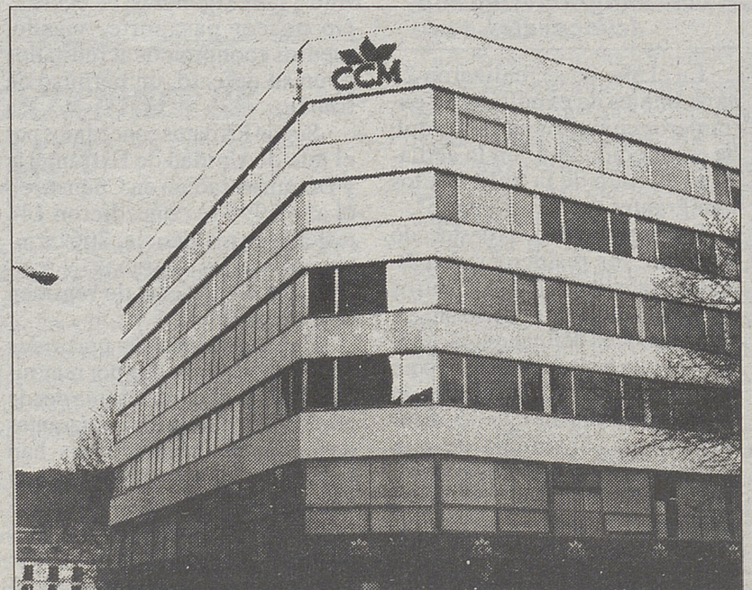
Fachada de la CCM en Cuenca.
