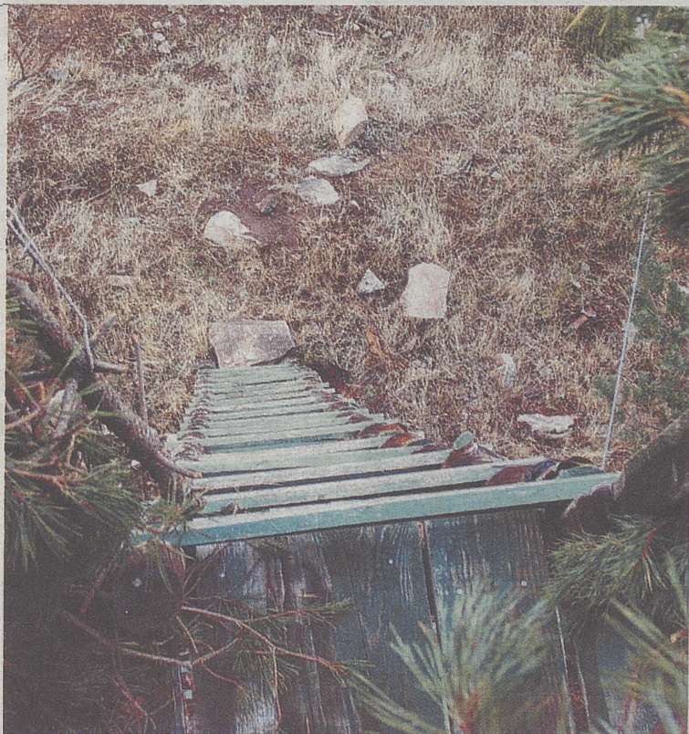
Escalera de subida a una de las torretas.
