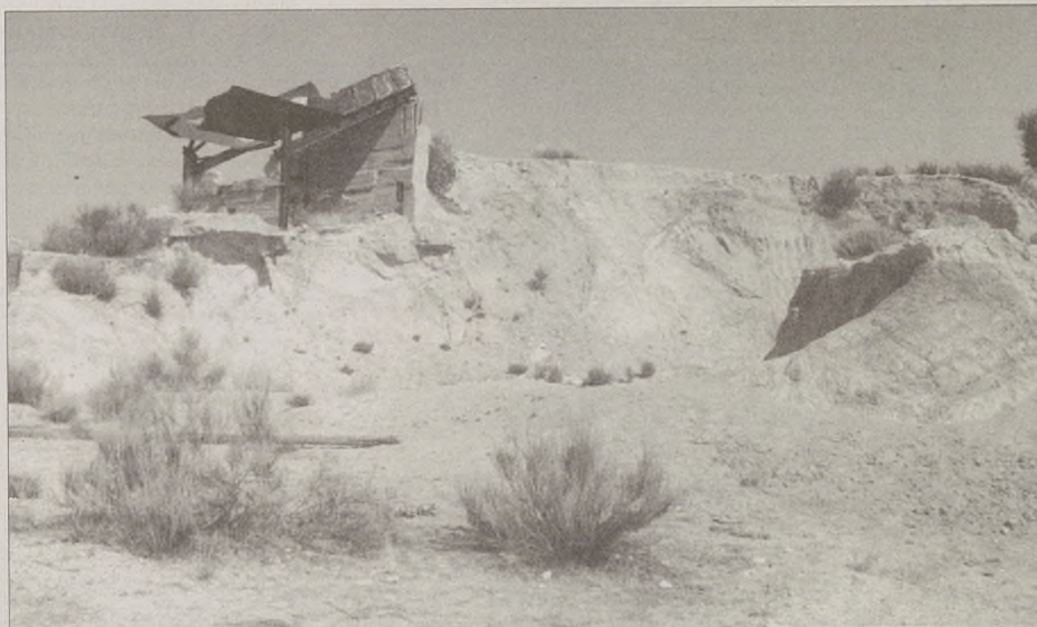
Foto de archivo del estado de las obras de la C-501 tras la paralización.
