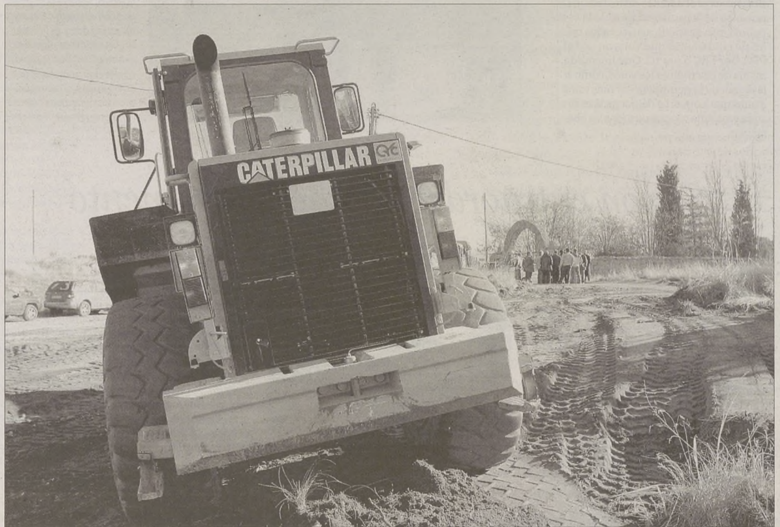
Una máquina excavadora comienza el movimiento de tierras en el Plan Parcial Tiro de Pichón. /ANTONIO BARTOLOMÉ
