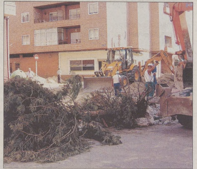
Imagen del árbol arrancado en la calle del Teso Nuevo. / GARCÍA
