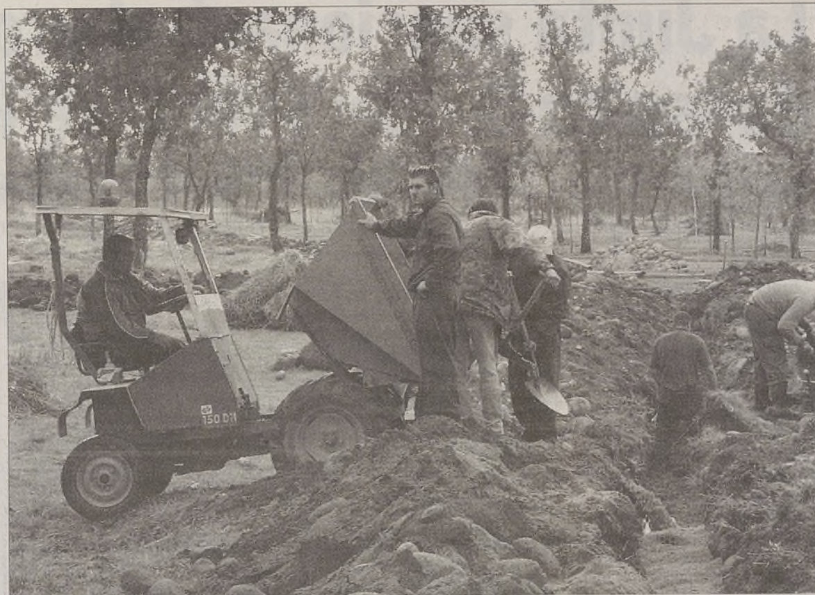
Imagen de archivo de los trabajos que se están realizando en el camping de Candeleda. / GARCÍA
