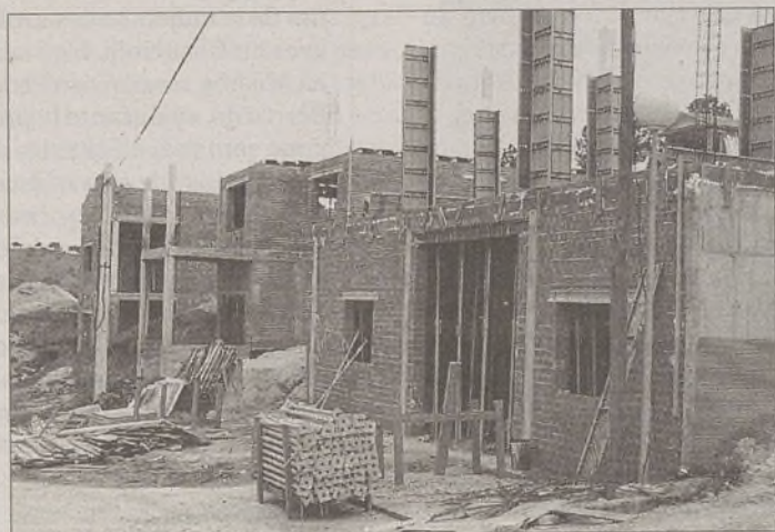
Estado de las obras de las viviendas sociales de Lanzahíta. / GARCÍA
