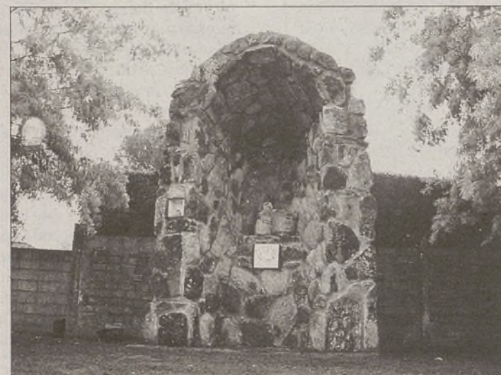
Estado actual de las obras de la réplica de la gruta de Lourdes. / LACABA
