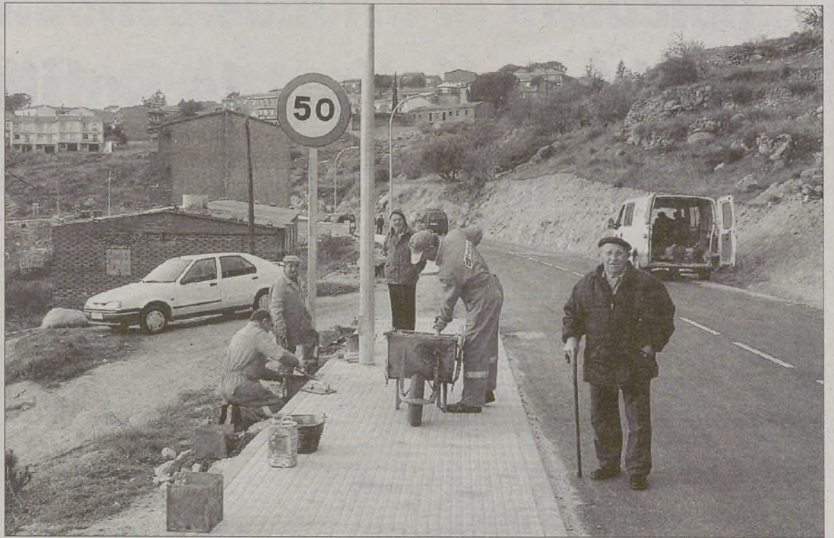
Los obreros dan los últimos retoques a la carretera. / M.T.
