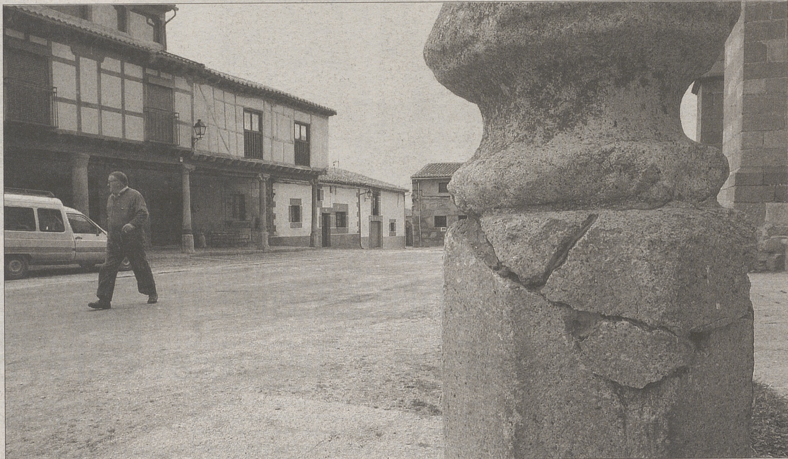
El deterioro de esta columna es un ejemplo de la situación en que se encuentra Bonilla. / PABLO REQUEJO
