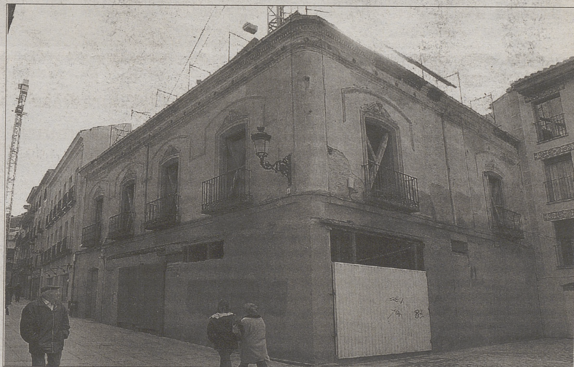
Casa en la calle Reyes Católicos que recuperará su fachada original de la planta baja. / ENRIQUE
