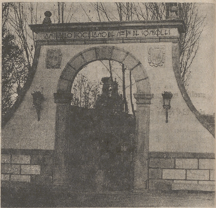
Arco de acceso al campillo del Santuario después de su restauración
