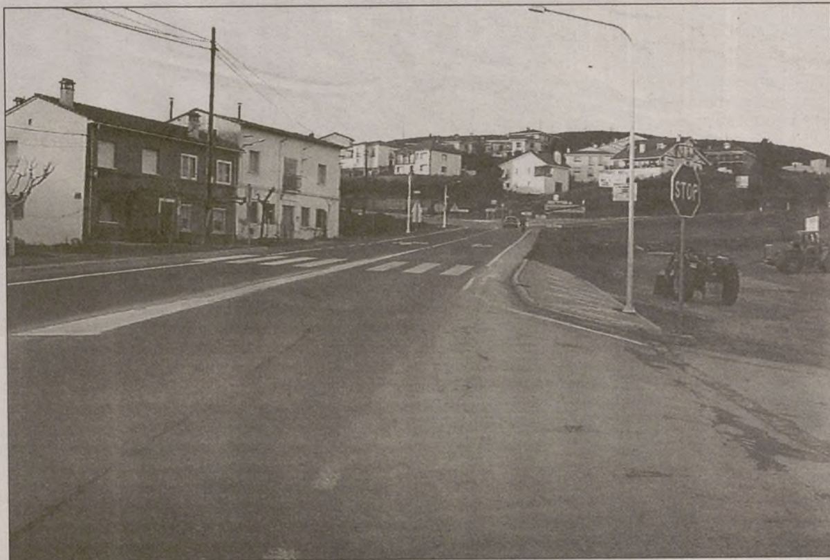
Entrada a la localidad de Ramacastañas por la N-110 / LACABA
