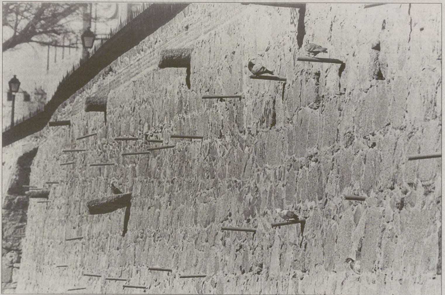
Muro de contención del Paseo del Rastro con las salidas de agua / ENRIQUE
