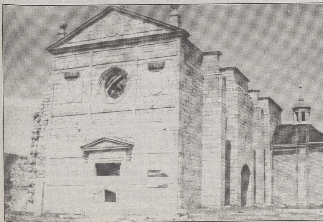
Convento de San Pablo de Las Navas del Marqués. La Junta inició su restauración, pero sólo realizó la primera fase. FOTO: ROSADO.
