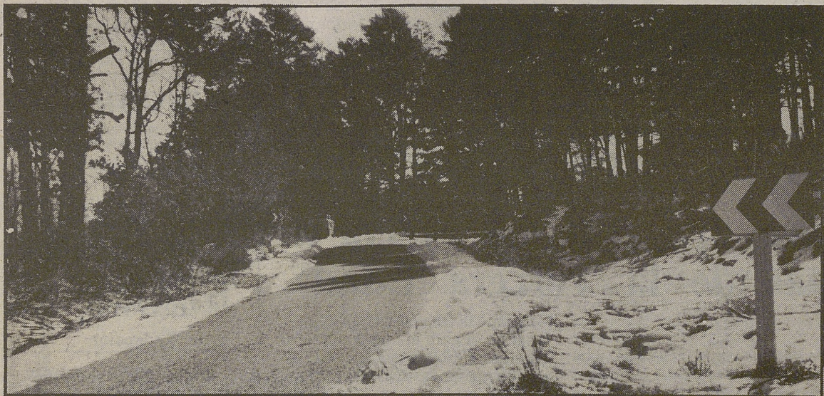
Se están cortando los árboles existentes junto a la calzada.
