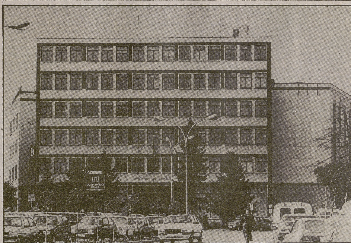
Edificio principal en Avila, del Patrimonio Sindical Acumulado (antigua AISS)
