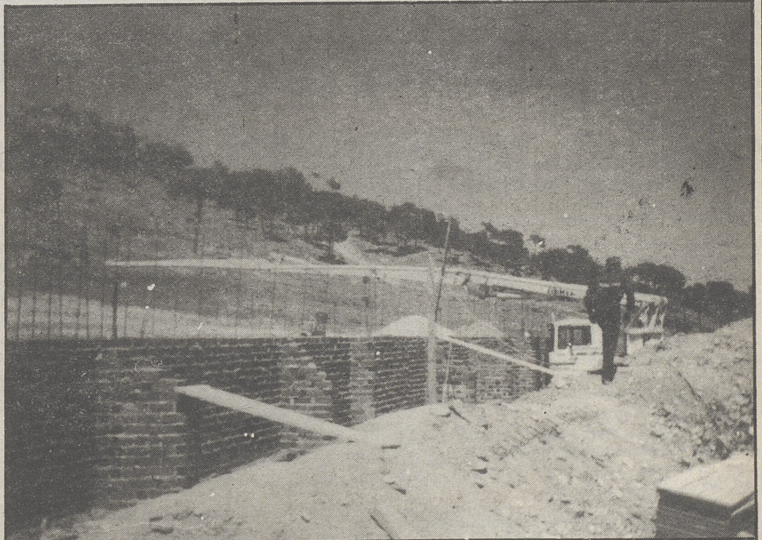
Obras en la piscina municipal.
