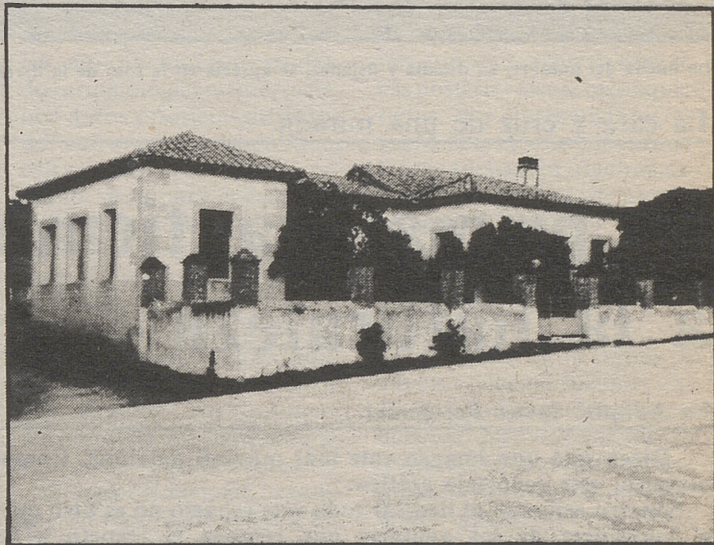
El abandono del edificio del antiguo colegio es patente
