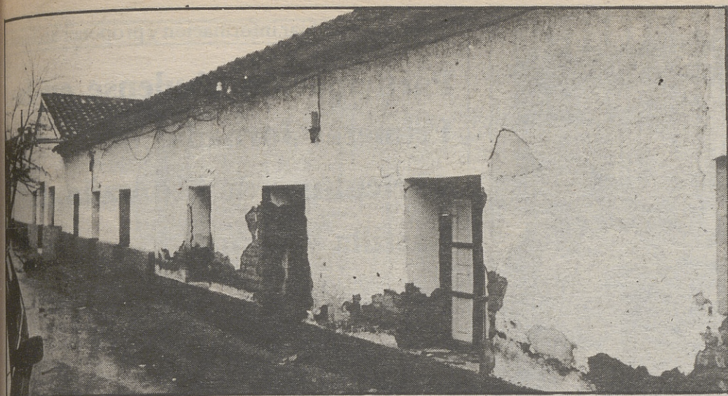
El Ayuntamiento pensó primero en ceder el lugar que ocupan estas viviendas, aunque actualmente se está pensando en otro. VICTOR GONZALEZ
