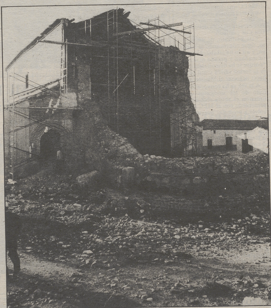
Obras de reparación y restauración de la iglesia de Orbita.
