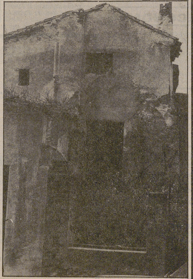
Un ejemplo de casa deshabitada, utilizada por grupos marginales.
