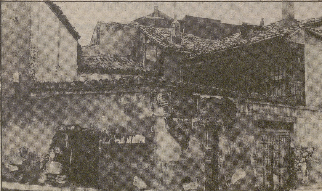
El deterioro es progresivo en la vieja manzana de casas deshabitadas.
