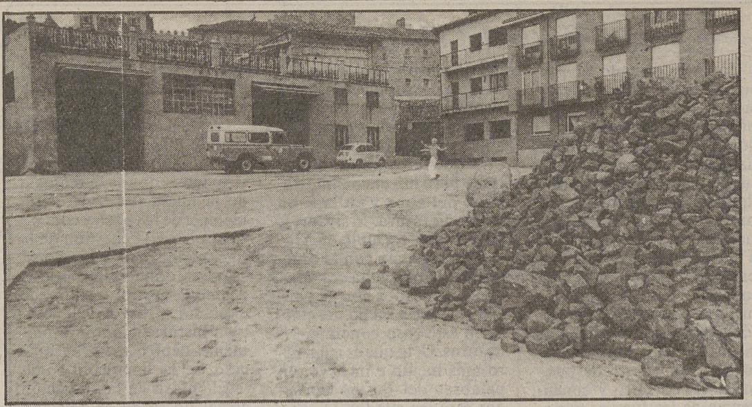
Los socialistas preguntan por la paralización de las obras de la Plaza de Las Losillas.
