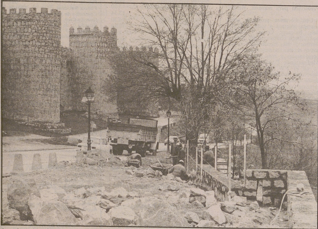
Las obras del paseo, a buen ritmo.
