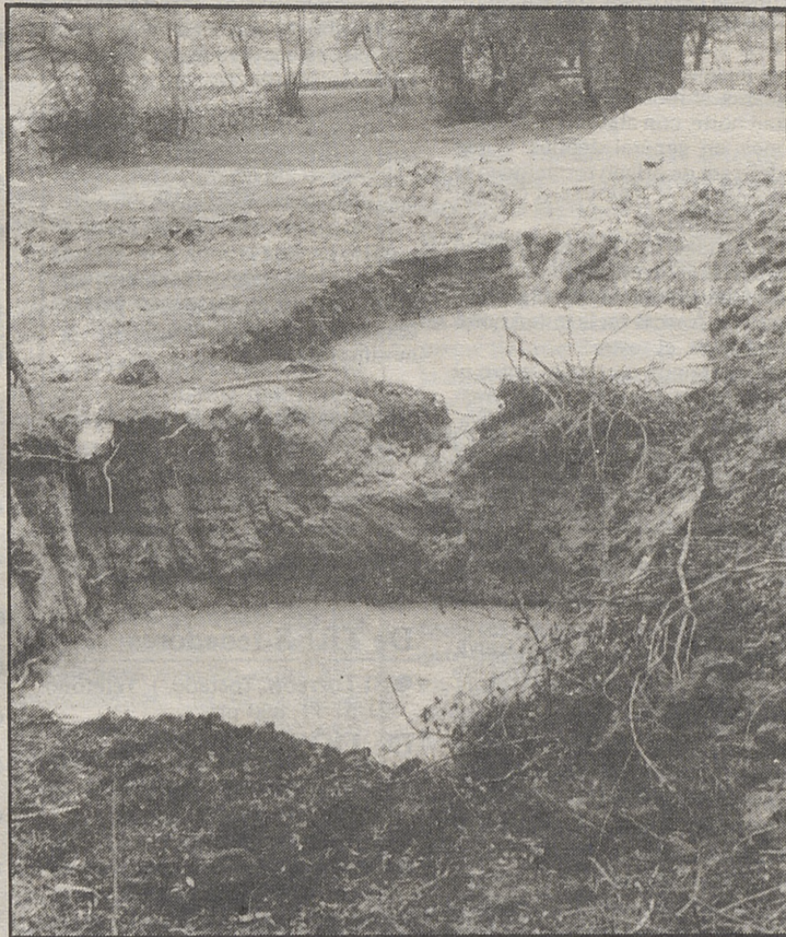
Junto al puente de la carretera de El Fresno se han hecho pruebas para un nuevo sondeo. Sin embargo parece que el propósito de extraer agua en ese lugar ha sido abandonado.
