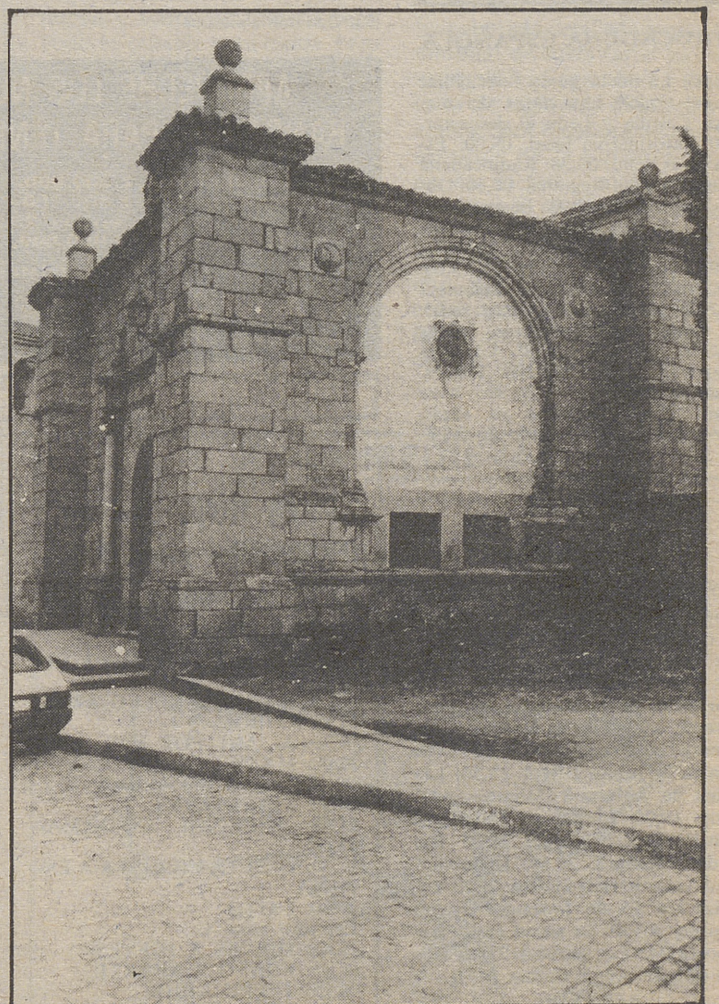
La puerta Oeste de la ermita del Humilladero será abierta tras la restauración que se lleve a cabo.
