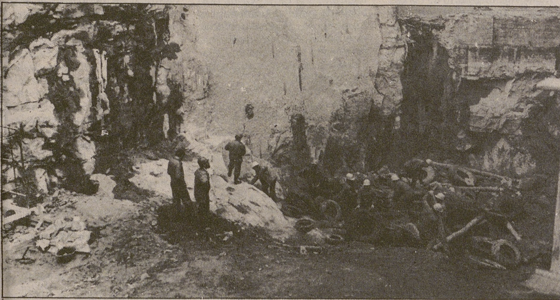
A varios metros de profundidad ya, se prepara el parapeto para la siguiente voladura. Aunque las explosiones se realizan con las máximas medidas de seguridad
