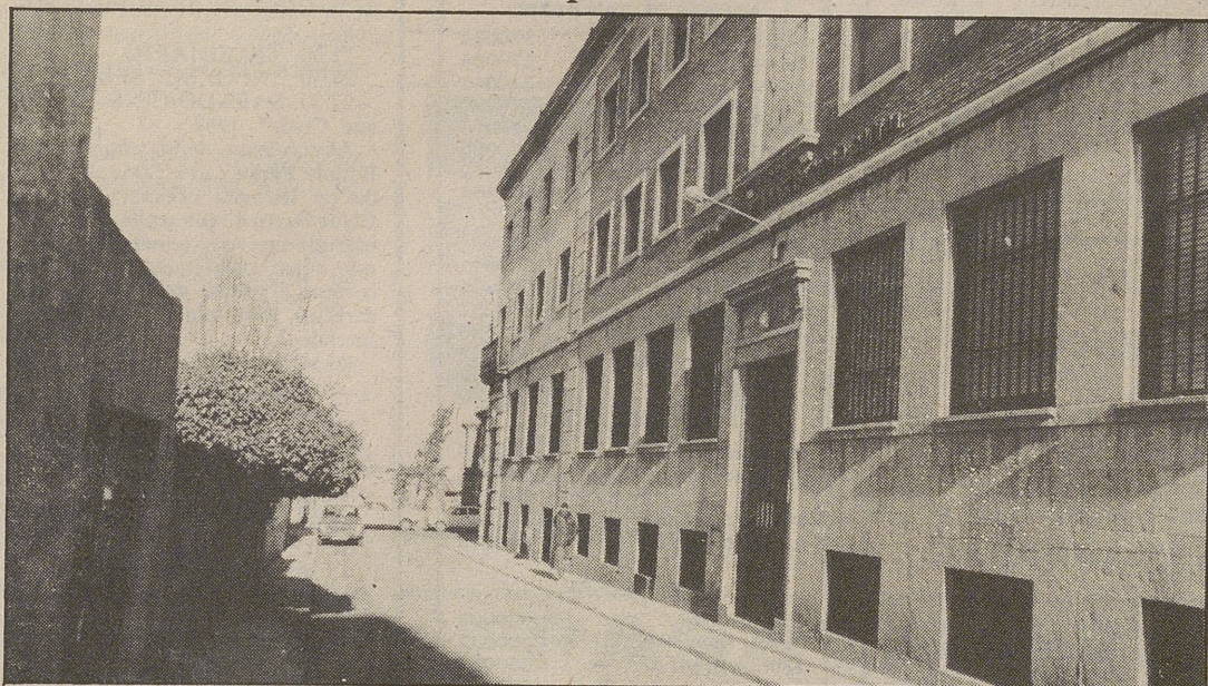
Cerca de un año durarán las obras del viejo Ambulatorio, sede definitiva del Centro de Salud.
