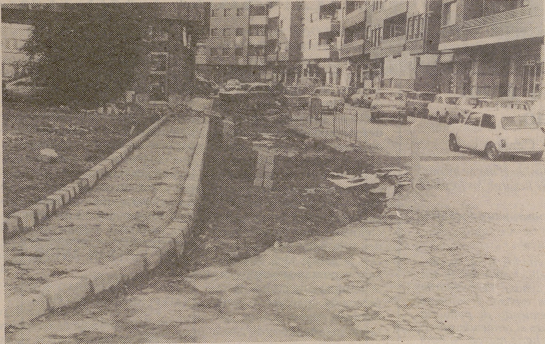
Continúan desarrollándose las obras de ensanche de la calzada en la avenida de Portugal. Al haber quedado establecida la nueva alineación de la calle, se han quitado aproximadamente dos metros de la anchura del jardín de la plaza de Salamanca, en beneficio del espacio dedicado a la circulación rodada en la calle.—(Foto: LUMBRERAS)
