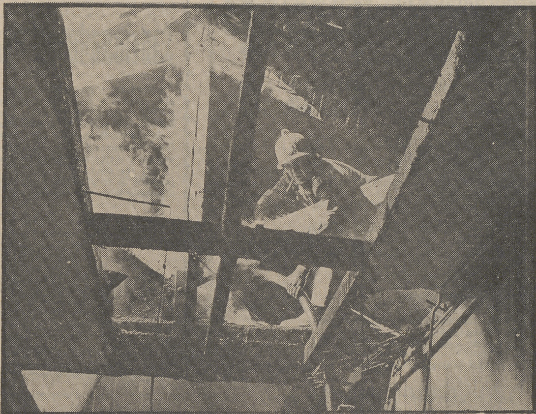
EDIFICIOS, FORESTALES, SALVAMENTO Y FALSAS ALARMAS
