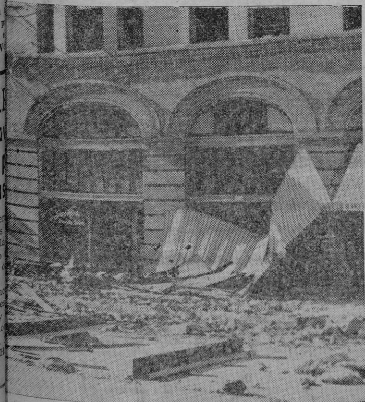
El temblor de tierra sufrido por la ciudad de Bakersfield, California, causó numerosos daños en esta población, de unos cincuenta mil habitantes. El hotel Tegeler y el edificio Broser, dos de los inmuebles que sufrieron mayor daño, aparecen en la fotografía.
