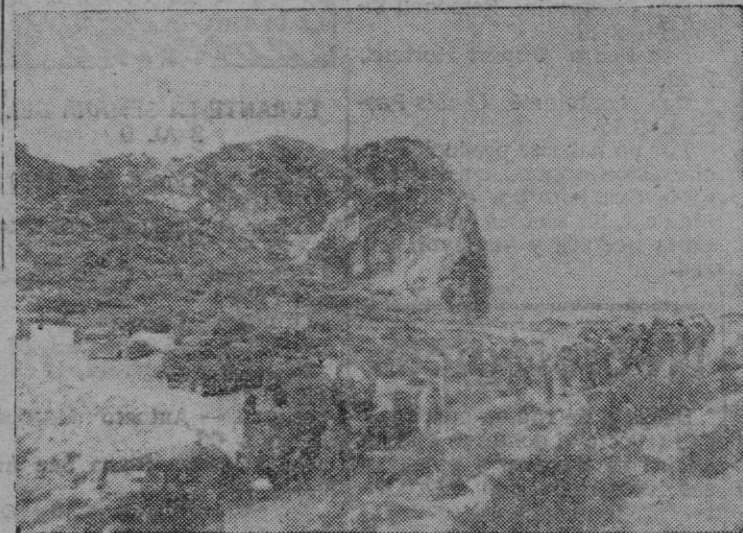
Vista de un tramo de la nueva carretera, desde el que se divisa espléndido panorama. (Foto Reportajes Palma)
