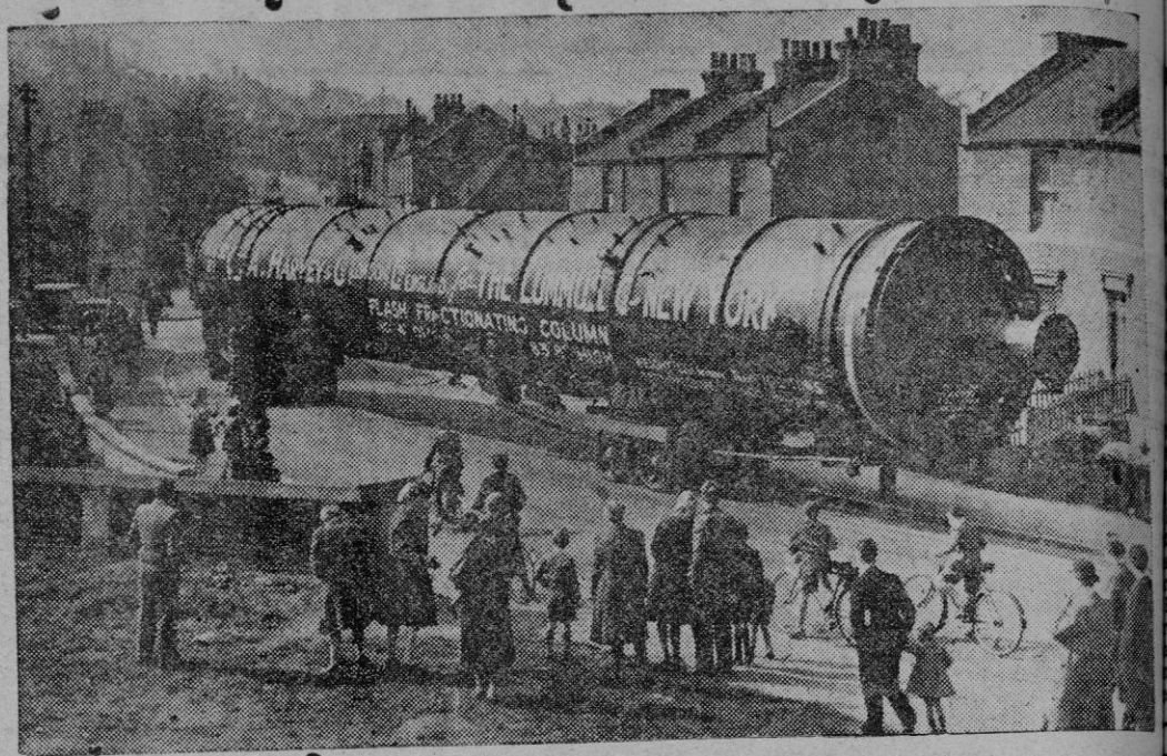
La foto capta el momento de ser transportada esa colosal torre de acero por las estrechas calles de Woolwich para ser inmediatamente embarcada rumbo a Venezuela.
