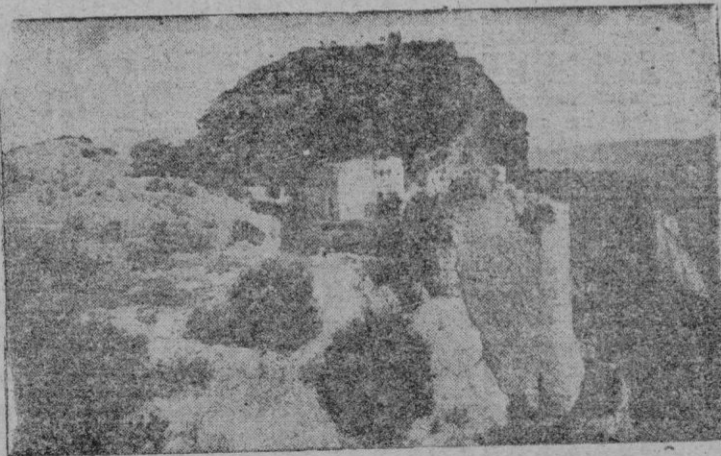
Vista general del Castillo de Alaró
