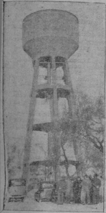
Torre de 26 metros de altura con el gran depósito de presión con capacidad para 250.000 litros de agua. (Foto CASTELL)
