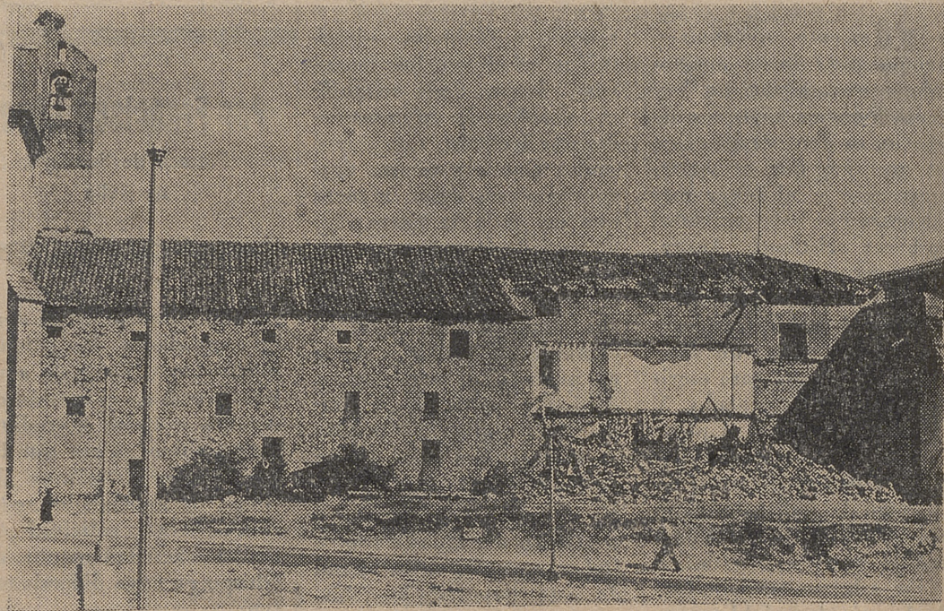
Han comenzado las obras de derribo del antiguo convento de las Clarisas, situado en la plaza de Santa Ana. Las religiosas se trasladaron hace más de dos años a un nuevo edificio, quedando el convento viejo vacío y en unas condiciones bastante deficientes, ya que en algunas de sus partes amenazaba ruina. Ahora, parte de este viejo convento (parece ser que lo que era iglesia quedará en pie) está siendo derribado y, al parecer, en su lugar surgirán modernos grupos de viviendas.—(Foto: LUMBRERAS).
