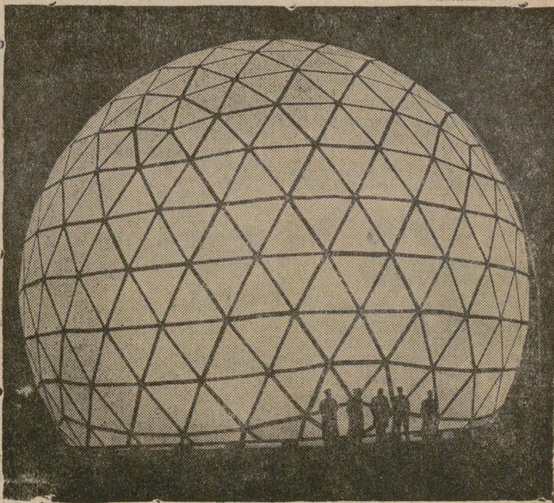
Esta gigantesca cúpula de plástico, que mide 21 metros de diámetro y unos 15 metros de altura, ha sido construida por la división de plásticos reforzados de una de las más prestigiosas empresas de electricidad. Diseñada para proteger equipo radárico, puede resistir vientos huracanados y temperaturas bajo cero. Consta de 300 secciones grandes, empernadas, y se dice que es la mayor estructura de plástico reforzado hecha hasta ahora en Europa.
