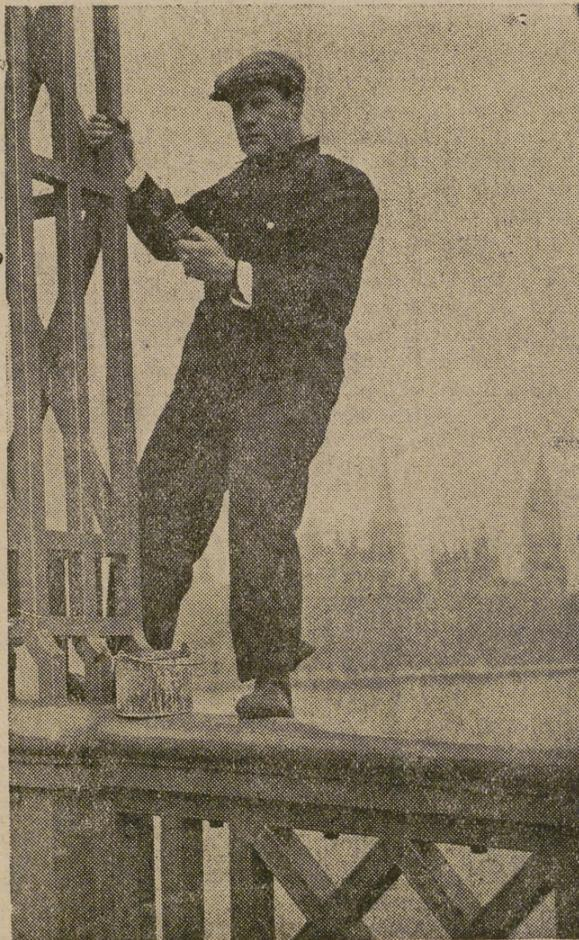
Alistair Simpson viste un «buzo» especial diseñado en la Gran Bretaña para la tarea de pintar estructuras sobre el agua, mientras se agarra al armazón de hierro del Lambeth Bridge, en Londres. Dicho traje tiene un dispositivo interior que mantendría al obrero a flote si tuviera la mala suerte de caerse al agua, pero no es notoriamente más pesado ni voluminoso que el «buzo» normalmente empleado en estos trabajos.
