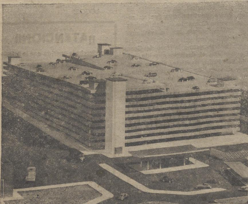
La maqueta muestra el sistema de doble espiral de pisos de aparcamiento en forma de rampas que permite separar completamente el tráfico ascendente del descendente. Además de los elevadores para pasajeros y escaleras de los cuatro ángulos, habrá dos elevadores de automóviles, especialmente para transportarlos por encima del cuarto piso.
