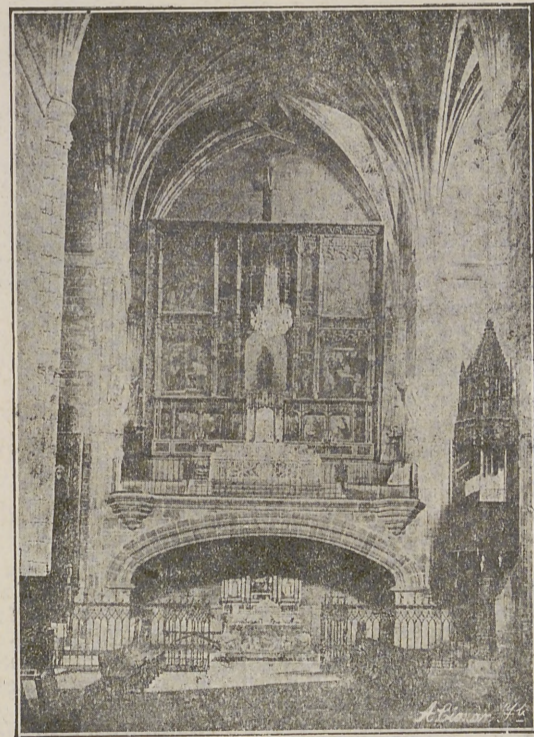
Interior de la Iglesia del Monasterio de Santo Tomás
