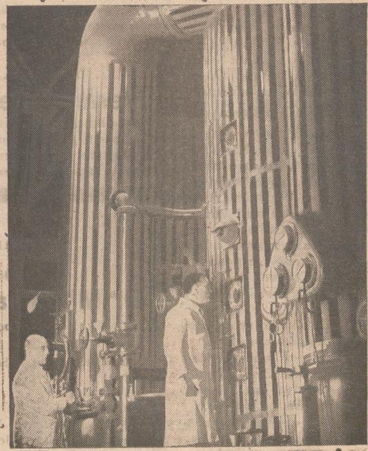
La salmuera purificada se eleva, por medio de bombas, a las calderas de evaporación donde se somete a determinados grados de calor y de vacío, hasta que se forman los menudos cristales de la sal de mesa
