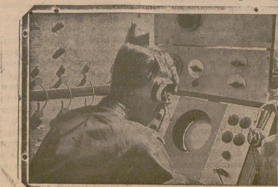
Con estos aparatos de rayos catódicos se informa a la aviación de las condiciones atmosféricas en un radio de acción de miles de millas.
