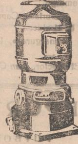
Con motor monofásico ideal para casas particulares hasta 900 litros por hora, y 12 metros de altura manométrica.
