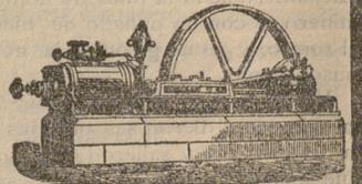
Máquina de vapor fija horizontal
