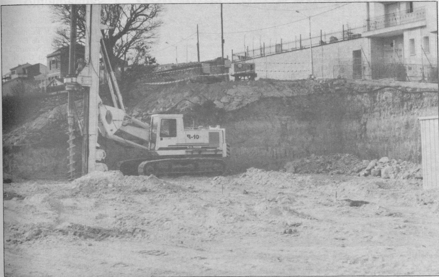
Un momento de las obras de construcción del nuevo hogar para la tercera edad, cerca del cual se han hallado los restos arqueológicos. S. GUIJARRO
