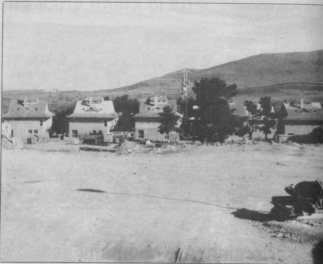
En total son 44 viviendas las que han sido paralizadas por el Ayuntamiento.
