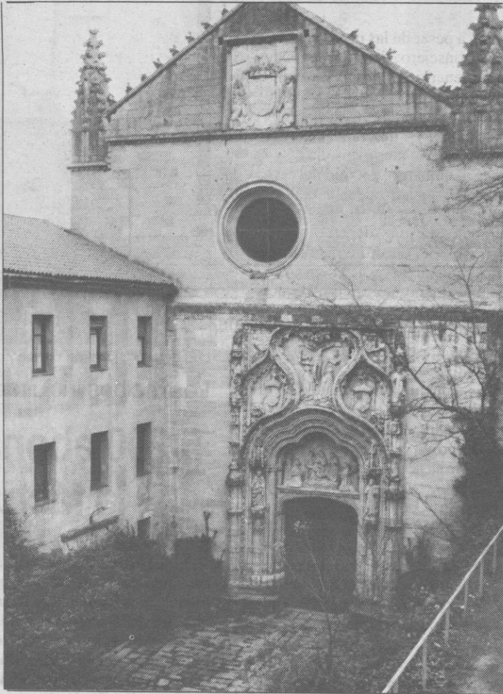
El proyecto daba al edificio un uso polivalente.
