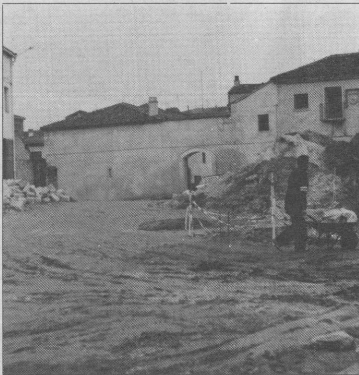
Esta fase de las obras contempla la urbanización de la plaza.
