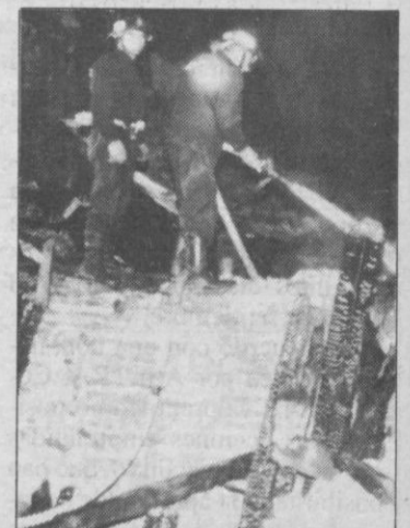
Extinguiendo un incendio.
