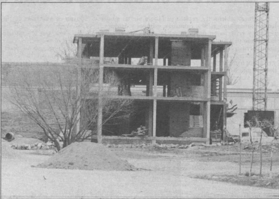
Construcción recuperó casi 60 puestos de trabajo durante el mes de julio.
