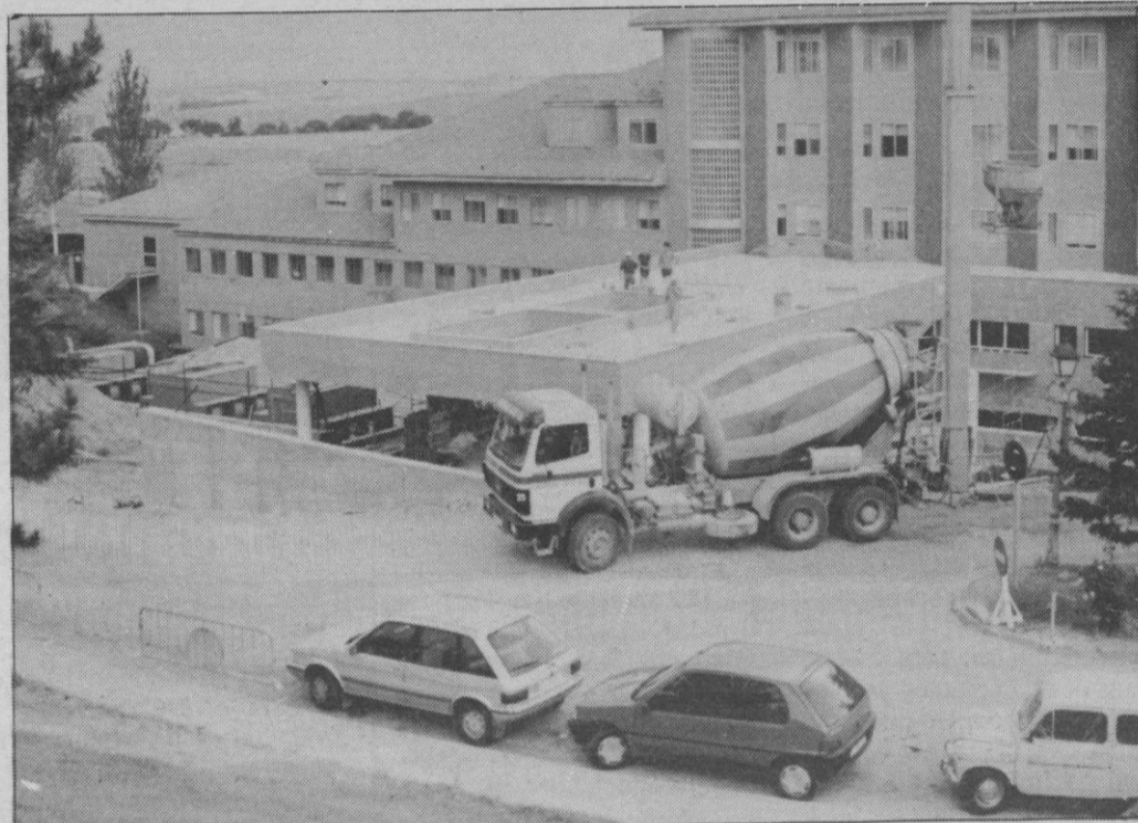
Los pacientes no se han visto afectados por el desarrollo de las obras en el Hospital. PEÑALOSA
