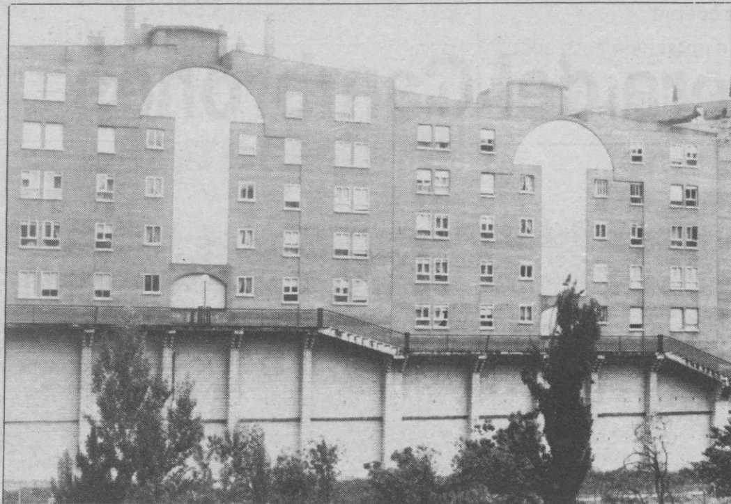
La planta baja de este edificio de la Vía Roma albergará la Extensión de Graduado Social.
