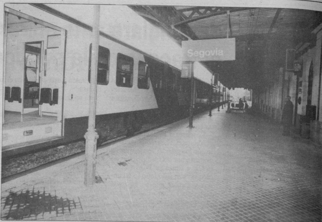
La estación está siendo sometida a obras de remodelación.
